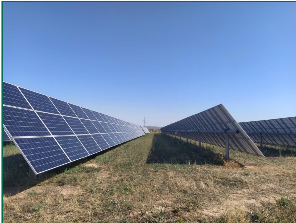
Fotografía 1. Vegetación entre placas actualmente.
